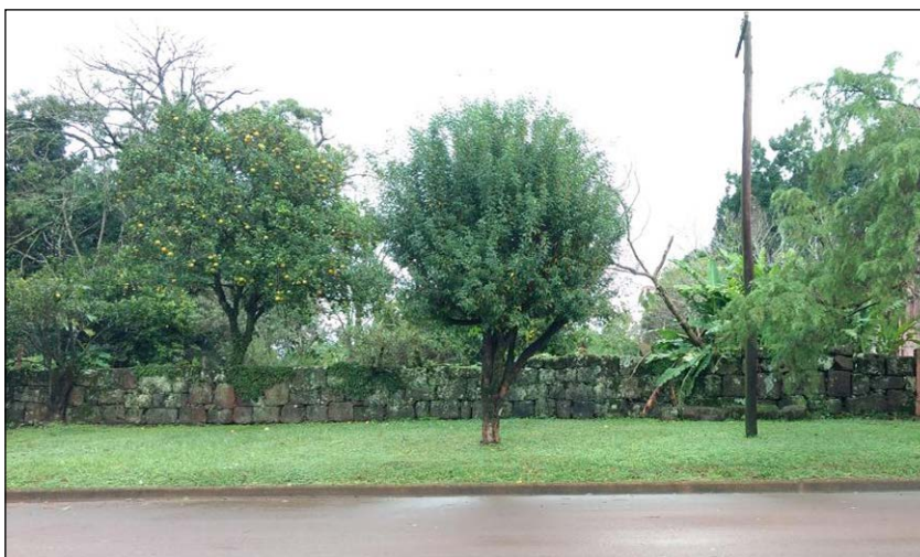
Figura 2. Muro de rocas itacurú que forma parte del frente de una vivienda particular.
