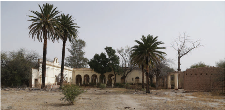
Imagen 3. Foto actual de la ex-bodega La Perseverancia
