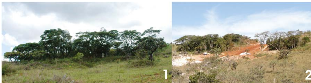
Imagem 7. 1) Vegetação no interior do tanque (2010); 2) Destruição do tanque para implantação de estrada (2015).
