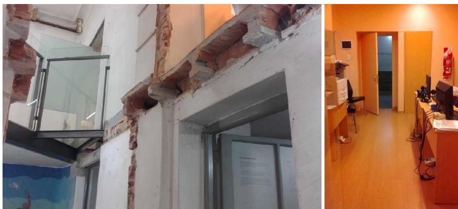
Figura 9. (A la izq.) Marcas de la demolición de parte del entrepiso y colocación de baranda vidriada. Fuente: relevamiento personal (25/07/2018). Figura 10. (A la der.) Habitación remodelada en el entrepiso conservado, donde funciona el Archivo audiovisual. Fuente: relevamiento personal (25/07/2018).
