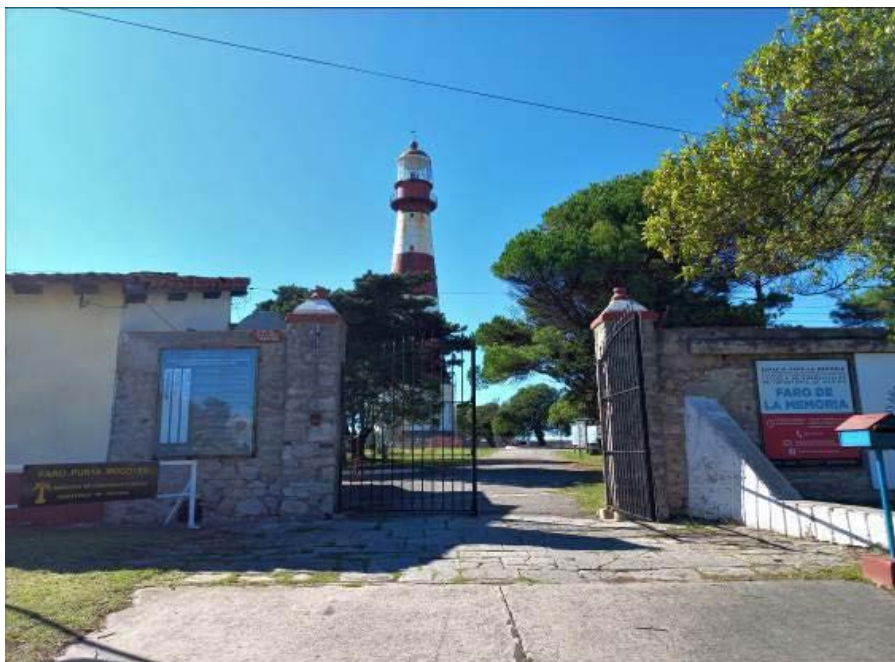
Figura 4. Portón de ingreso y carteles de señalización. Fuente: fotografía propia, 2022.
