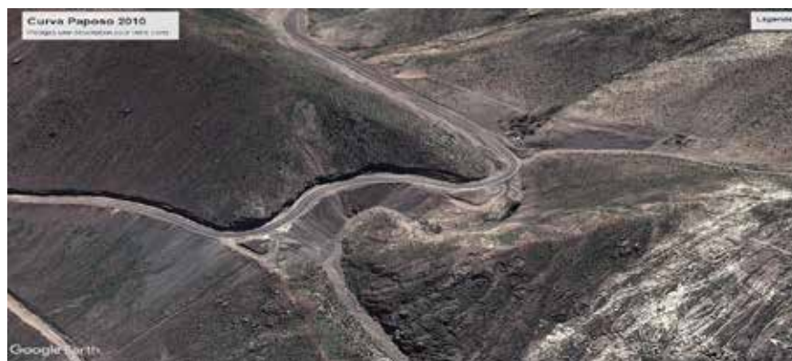
Figura 11. Curva de Paposo en 2010, al momento de la inauguración de la ruta asfaltada. Fuente: Google Earth (2023c).
