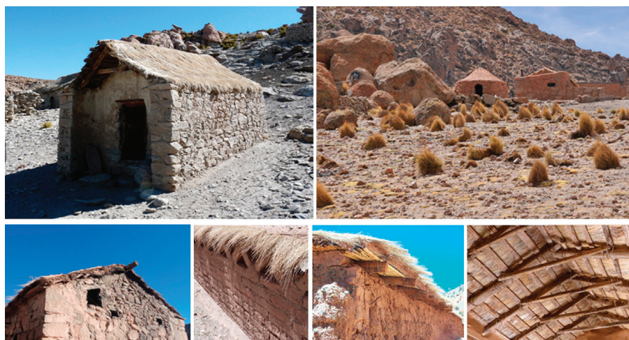
Figura 3. Técnicas constructivas en distintas arquitecturas en los alrededores de Coranzulí: techados de paja ( guaya , sup.) y mampostería de piedra y adobe; interior de techado a dos aguas con estructura de madera de cardón (inf.).
