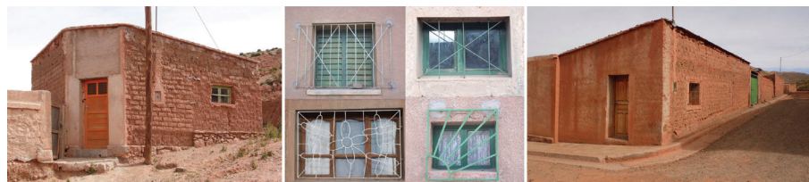
Figura 9. Utilización de revoques de cemento en ciertas caras de las fachadas y de rejas con distintos diseños en aberturas.
