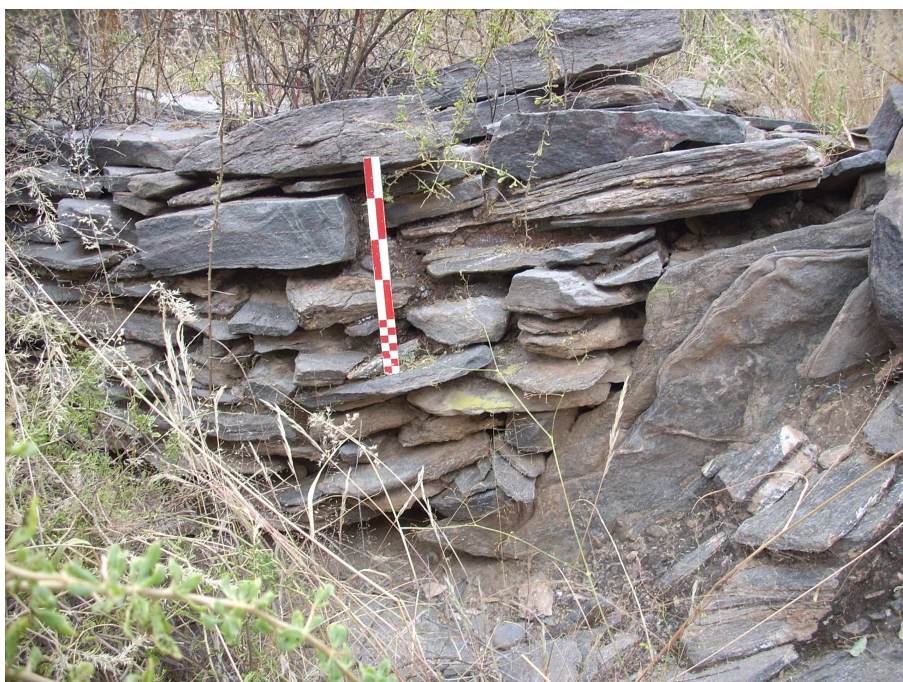
Figura 5. Apoyo del muro sobre roca madre. Muro oriental exterior del R15, en el sector II de MF1.
