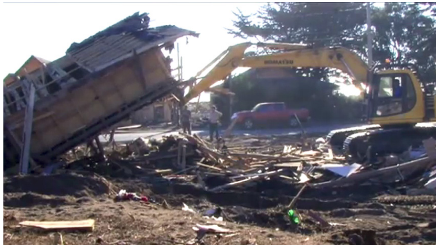
Figura 3: Performance de destrucción. Grúa levantando casa en Tres semanas después (Torres Leiva, 2010)
