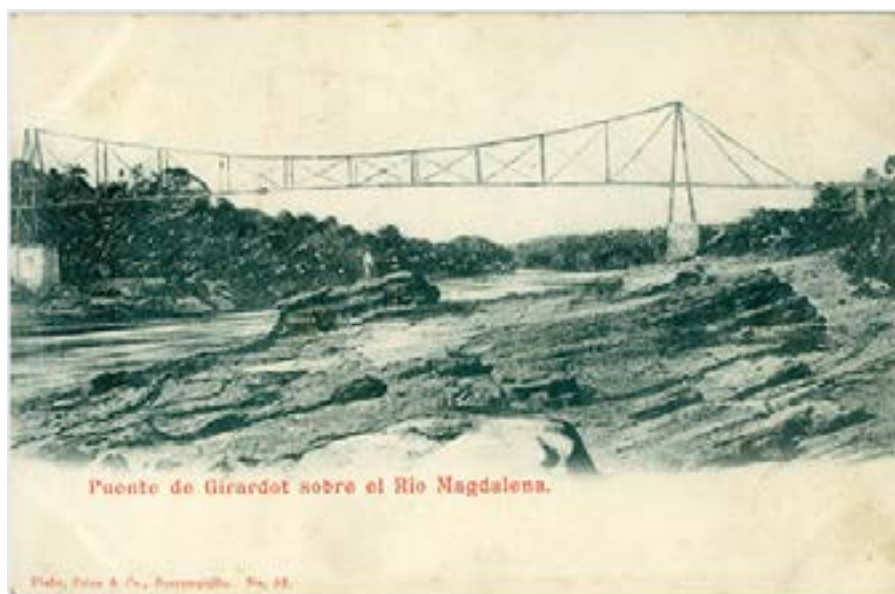
Figura 8. Flohr, Price & Co. Puente de Girardot sobre el río Magdalena (n°52, postal B/N, 1904).
