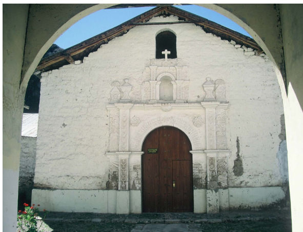
Figura 6. Fachada de La Inmaculada Concepción, Taurisma, 1687 (fotografía del autor)
