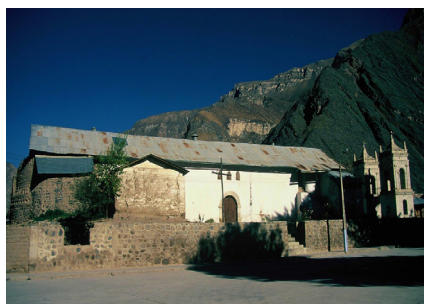
Figura 10. Lado izquierdo de la nave con portal lateral y sacristía de Nuestra Señora del Rosario, Tomepampa (fotografía del autor)
