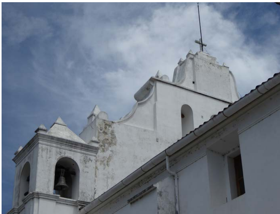
Figura 5. Detalle del coronamiento de la fachada y vista desde la parte de atrás de la iglesia de Santiago Apóstol, Chalchuapa.
