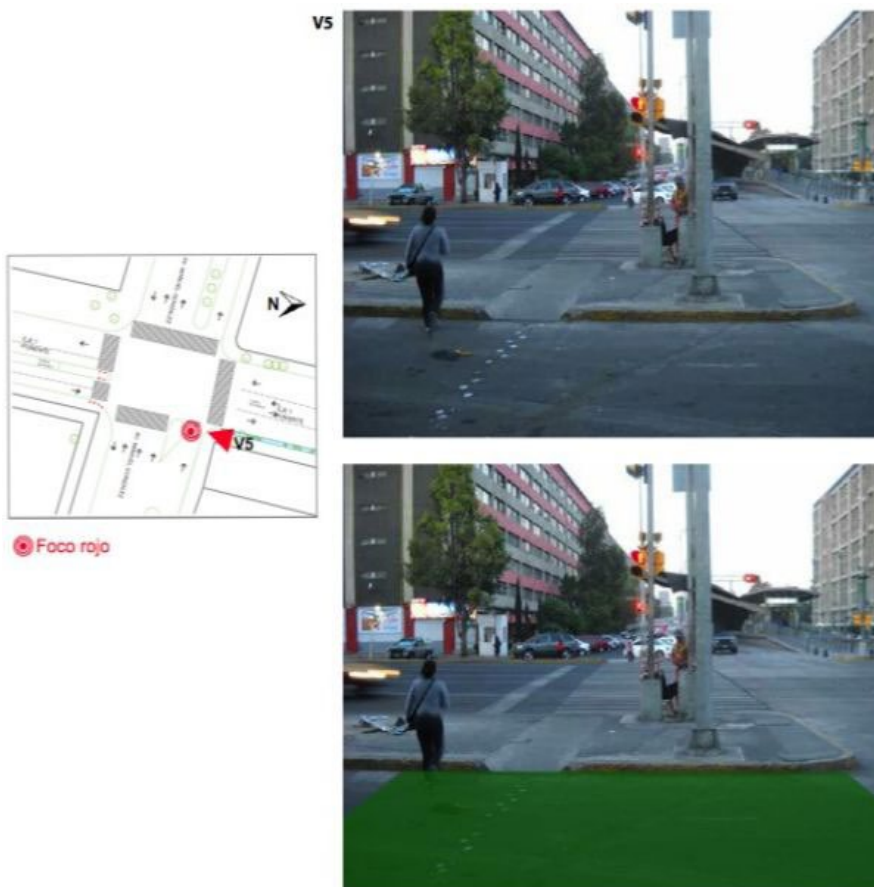
Figura 12. Falta de marcas en el pavimento. Fuente: elaboración propia.
