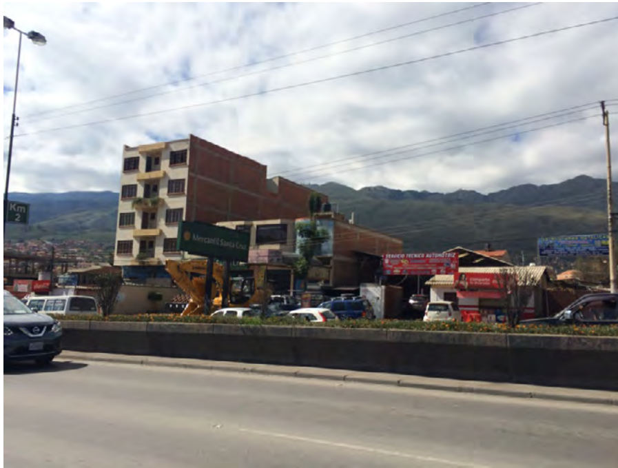
Figura 13. El banco, las tiendas y otras refacciones en la infraestructura del camino. Fuente: Fotografía propia. Tomada en 24 de febrero de 2017.
