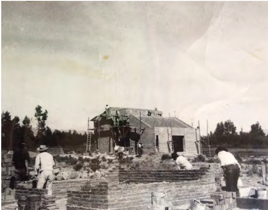
Figura 6. Construcción de las primeras casas (Urbanización El Castillo). Fuente: Archivos de José L. Tomada en 1971.
