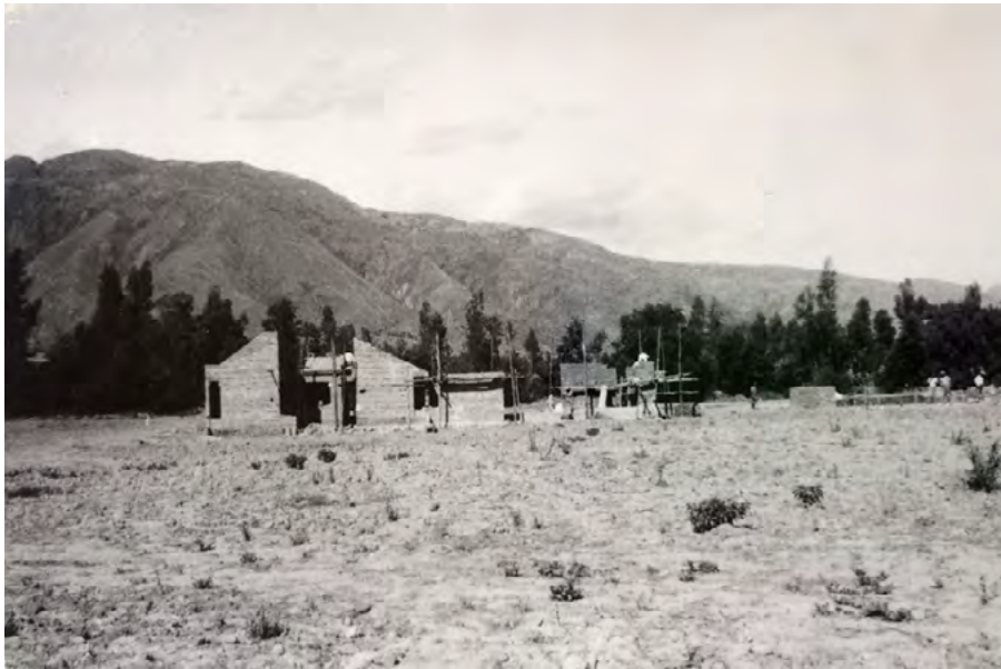
Figura 2. Casa de José y Ofelia, en construcción. Fuente: Archivos de José L. Tomada en 1970.
