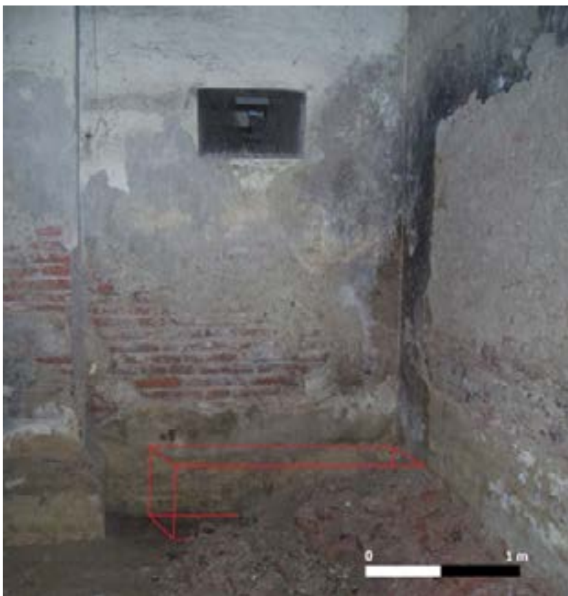
Figura 2. Cuarto donde se hallaba la antigua cisterna. En rojo, lugar del hallazgo de los restos óseos. Nótese la presencia de una ventana que conecta con una de las áreas de guarda de la División Antropología.
