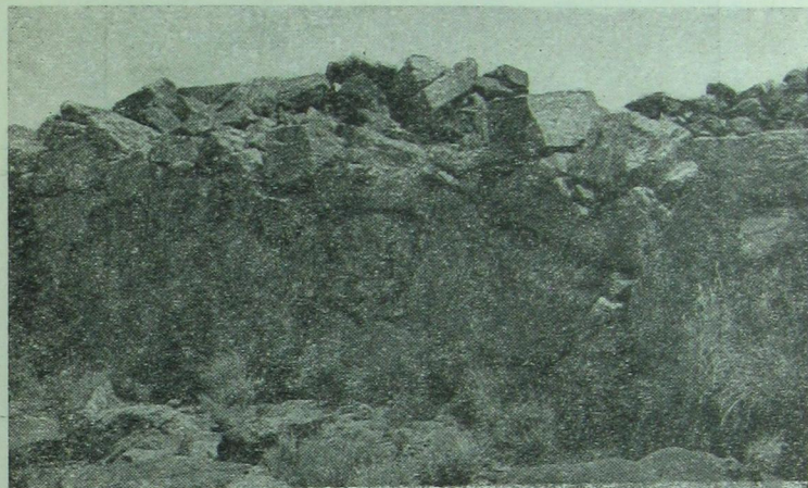
Foto 9 — Detalle del muro norte de la estructura nº 11.
