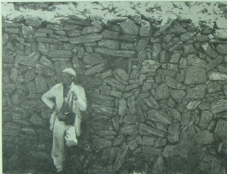
Foto 8 — Detalle del muro sud de la construcción n° 11.
