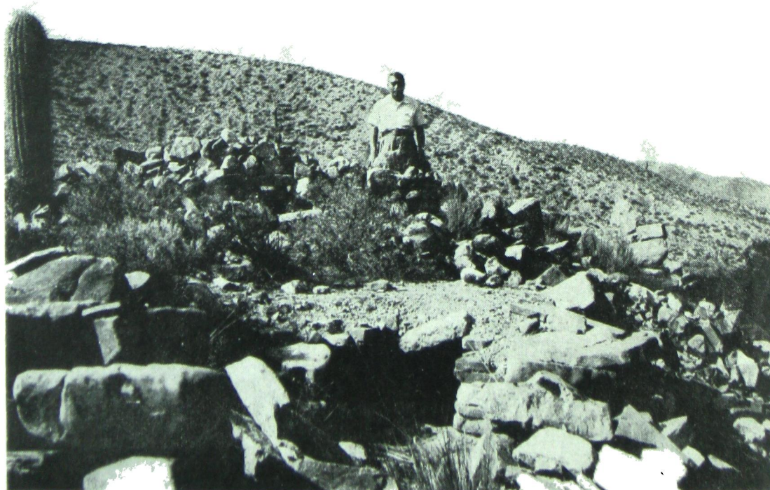
b — Aspecto de la construcción subterránea de la Quebrada de Yonacancha
