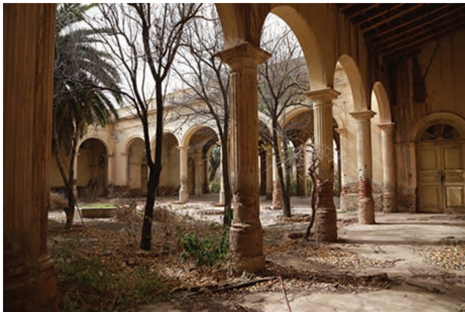
Imagen 4. Foto actual de la ex-bodega La Perseverancia
