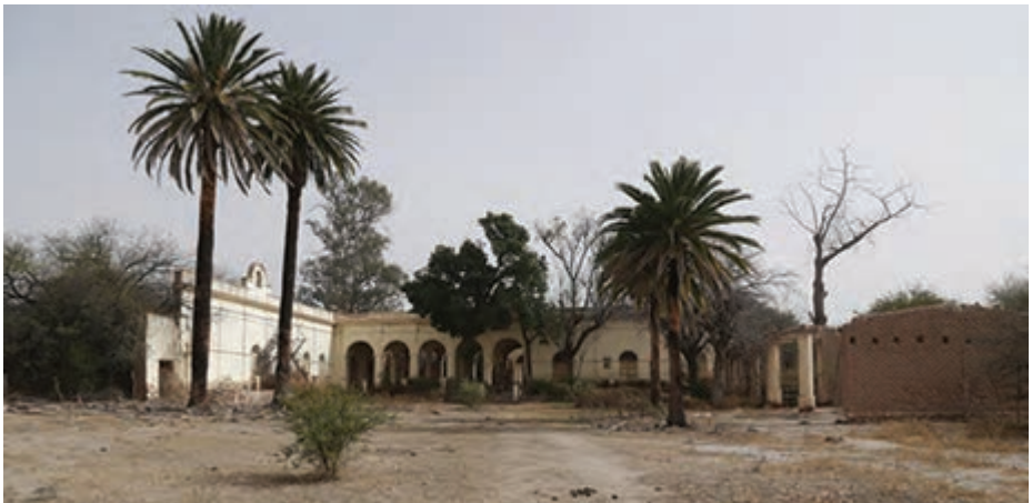
Imagen 3. Foto actual de la ex-bodega La Perseverancia
